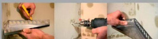
Bohrmarkierungen anzeichnen
